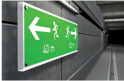
Fluchtwegschilder im Tunnel
