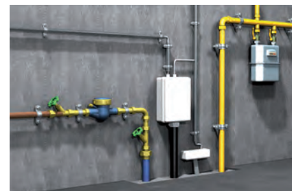
Befestigung von Leitungen
