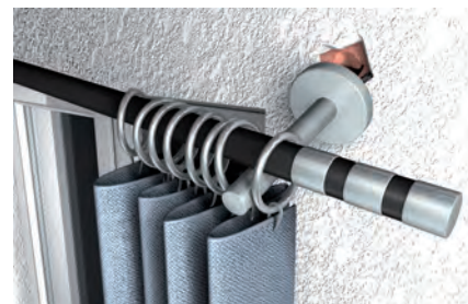
Reparatur ausgerissener Bohrlöcher
