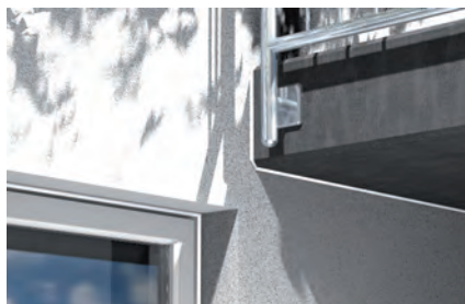
Anschlussfugen im Außenbereich
