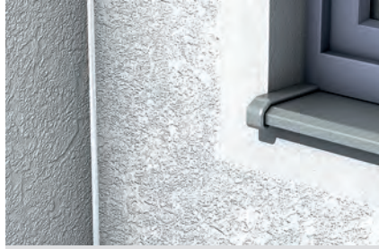
Anschlussfugen im Außenbereich
