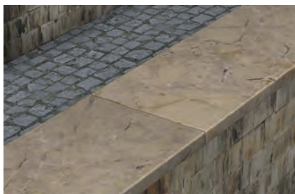
Mauerkopfabdeckungen
