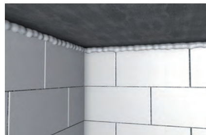
Schließen von Fugen im Rohbau
