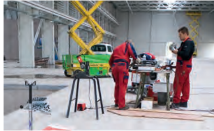
auf die Baustelle
