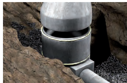
Abdichten von Beton-Schachtringen
