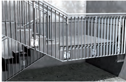
Stirnseitige Geländerbefestigung
