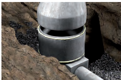
Abdichten von Beton-Schachtringen
