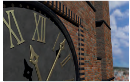
Sanierung von Vormauerschalen
