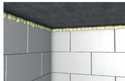
Schließen von Fugen im Rohbau
