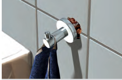
Reparatur ausgerissener Bohrlöcher
